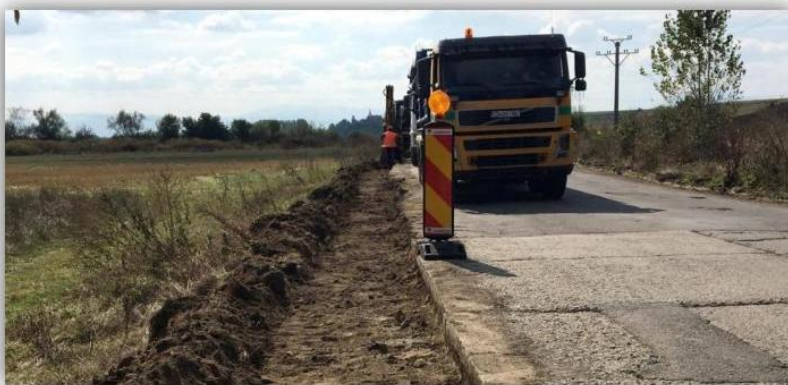
Au început lucrările de modernizare a drumului județean 112
