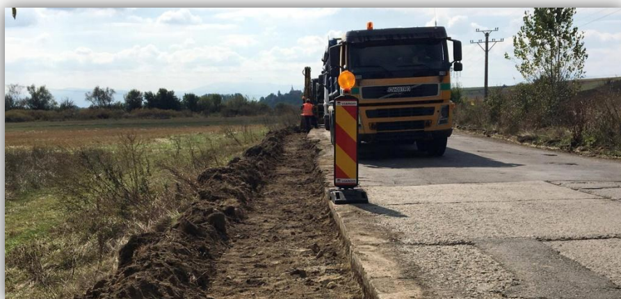
Au început lucrările de modernizare a drumului județean 112
